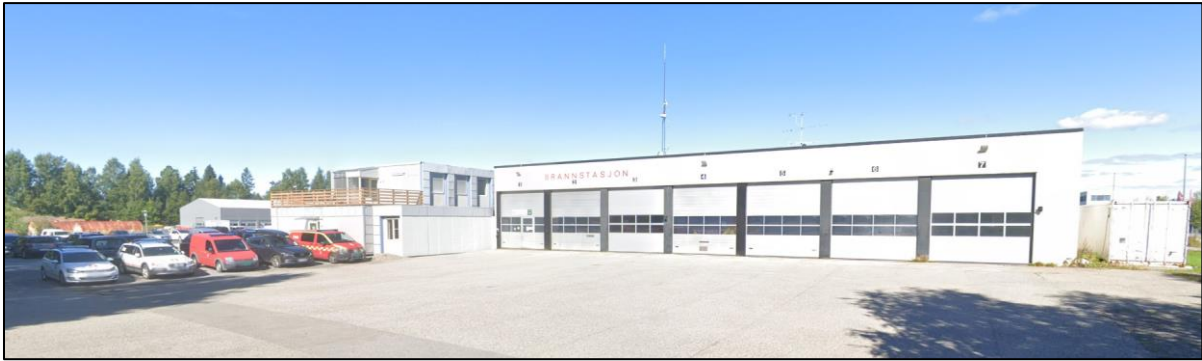
Figur 3: Dagens hovedbrannstasjon i Industrivegen 28 (Kilde: Google)
